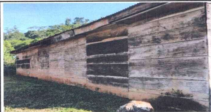
Foto 5: Se observa las paredes en mal estado por el agua.
